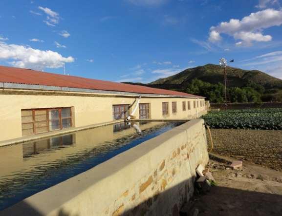
Watervoorraad in de tuin van het college > Aanleg van nieuwe waterleiding
